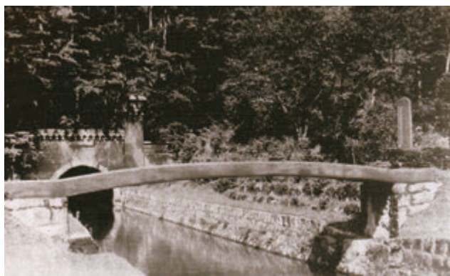
写真-1.2.2 琵琶湖疎水に架かるわが国最初の鉄筋コンクリート橋
