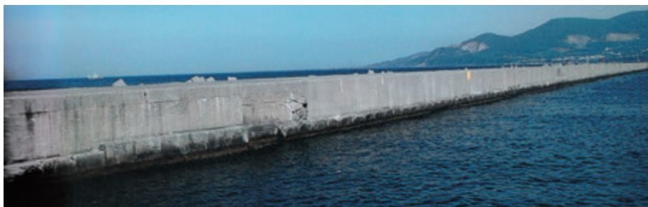
写真-1.2.3 小樽港北防波堤
