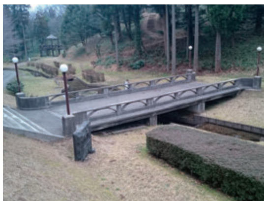
写真-1.2.4 移設して保存されている長生橋
