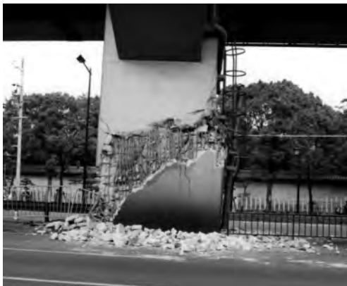
写真-1.5 道路橋の地震被害
