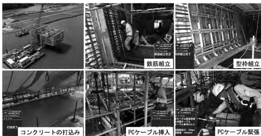
写真-1.9 張出し架設工法の施工例（株式会社日本ピーエス提供）
