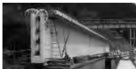
図 -2.4 T形断面の一例
