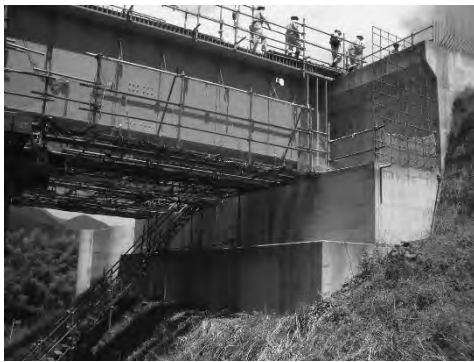
図 2.7 ローラー（移動）支点，ヒンジ（回転）支点
