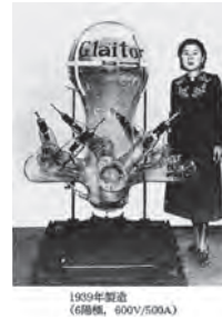
図 1-10 日本電池株式会社製の水銀整流器 (Glaitor) の姿写真
