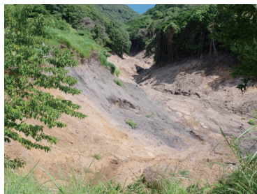
写真―2.1 盛土の崩壊開始地点
