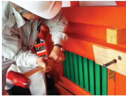
和釘打込みの様子
