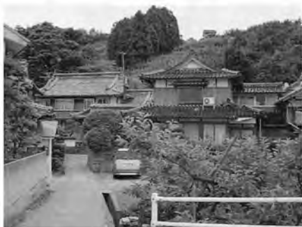
図 1.1.10 瓦屋根の例（鳥取県）
